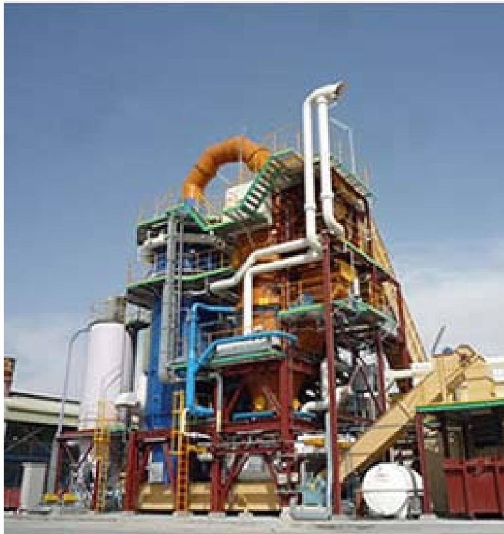
低碳直接熔融还原反应炉
